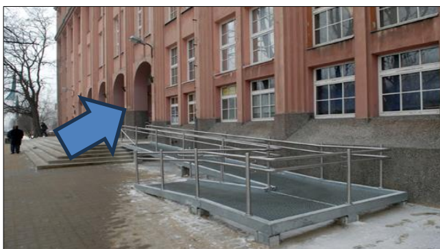
Zdjęcie 2. Gmach główny SGH – wejście główne
