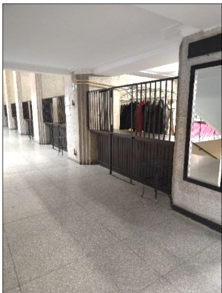
Zdjęcie 4. Szatnia w budynku głównym
